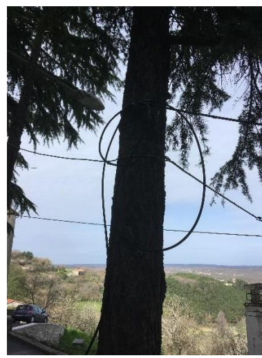
Slika 18. Telekomunikacijska infrastruktura pričvršćena na deblu
