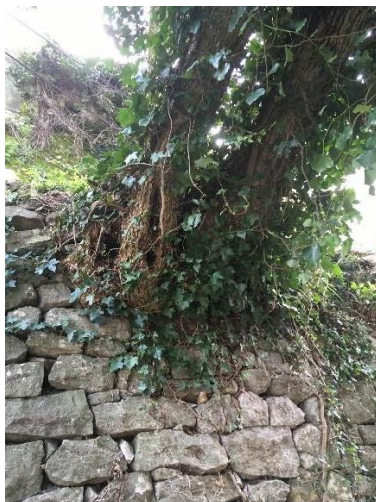
Slika 20. Stablo izraslo iz potpornog suhozida
